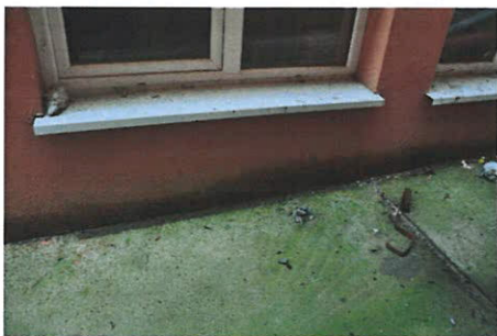
Foto nr. 7 – Aspect degradări în zona soclului datorită apelor meteorice
