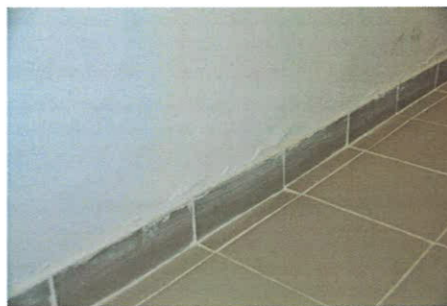
Foto nr. 8 – Aspect degradări finisaje datorită ventilării necorespunzătoare
