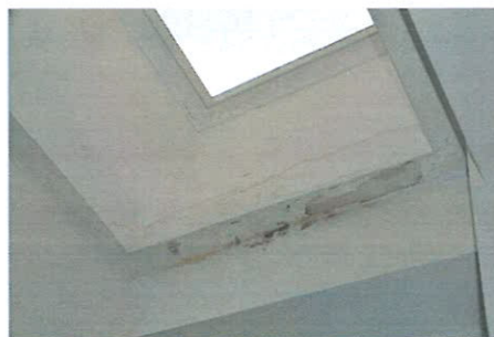
Foto nr. 10 – Infiltrații în zonele adiacente luminatoarelor
